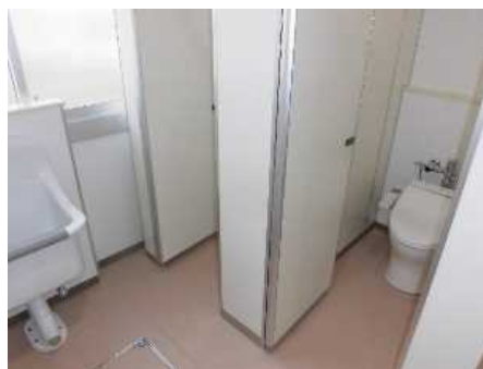
衛生を保ちやすい乾式・洋式トイレに改修
