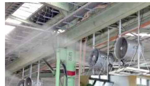
(整備の一例) 換気扇の設置
